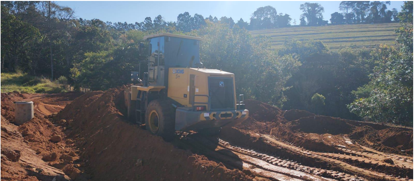
Foto 07, Conjunto Habitacional Cristais Paulista D, local onde será executado a Estação Elevatória de Esgoto.
