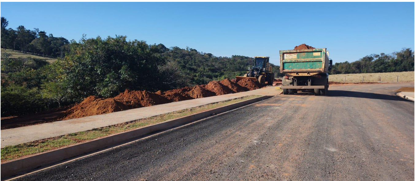
Foto 08, Conjunto Habitacional Cristais Paulista D, local onde será executado a Estação Elevatória de Esgoto.
