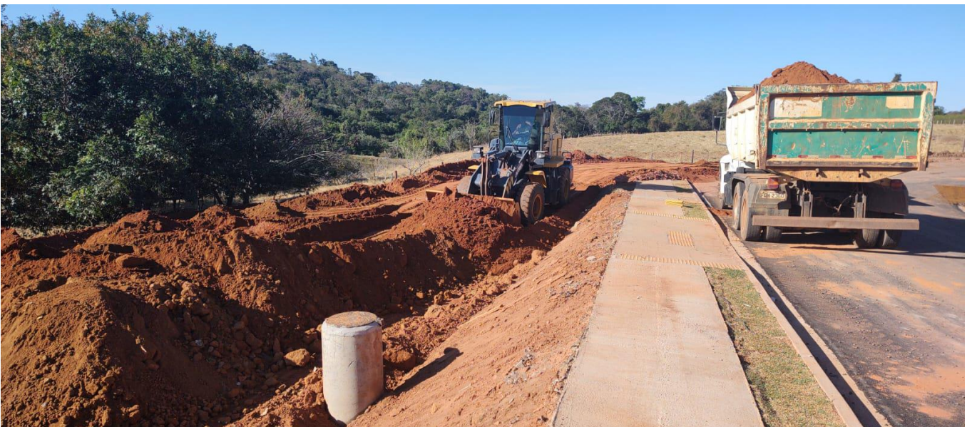
Foto 06, Conjunto Habitacional Cristais Paulista D, local onde será executado a Estação Elevatória de Esgoto. Execução de aterro para construção da E.E.E.
